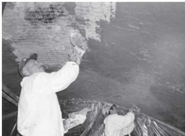
Нанесение состава «Кальматрон» вручную
