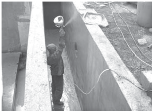
Нанесение состава «Кальматрон» механизированным способом
