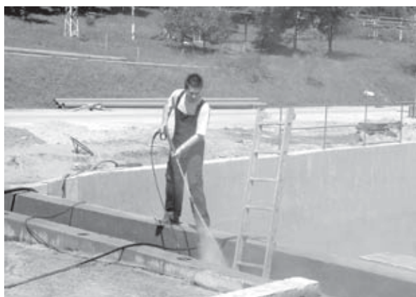
Очистка поверхности гидромонитором
