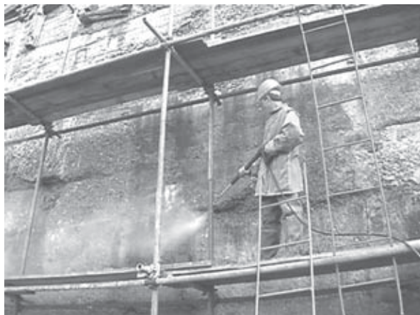
Нанесение состава «Кальматрон» вручную
