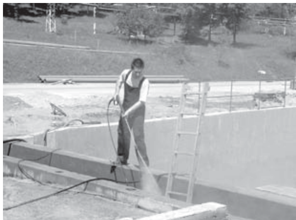
Нанесение состава «Кальматрон» механизированным способом
