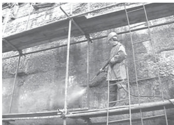
Смачивание бетонных поверхностей
